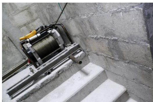
Fixation par ancrage
