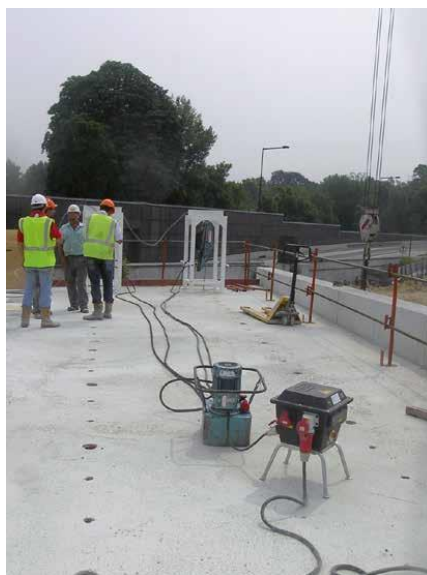
Installation sur chantier
