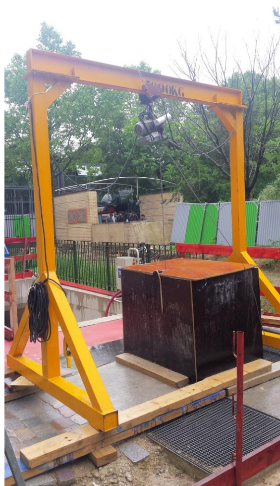
Installation sur portique
