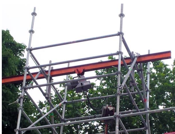
Installation sur fer fixée sur un échafaudage
