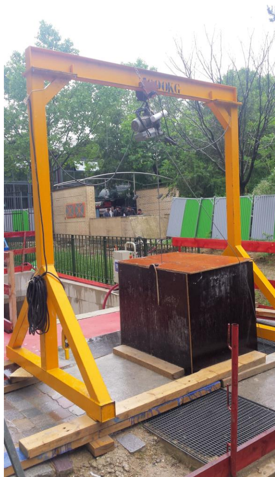
Installation sur portique
