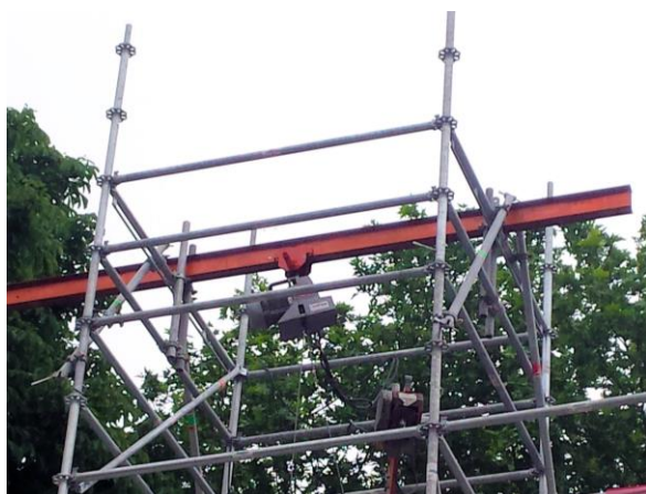
Installations sur fer fixé sur un échafaudage
