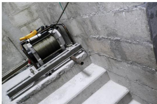
Fixation par ancrage avec des tubes d'échafaudage sur une dalle en béton.
