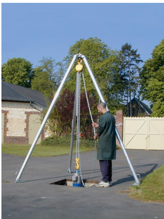
Travaux en réseaux souterrains
