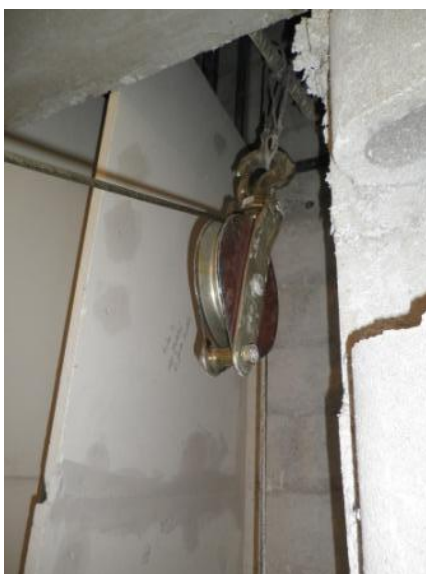
Poulie en situation de levage
