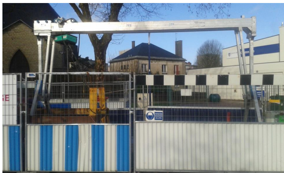
Installation sur chantier avec un palan électrique à chaîne
