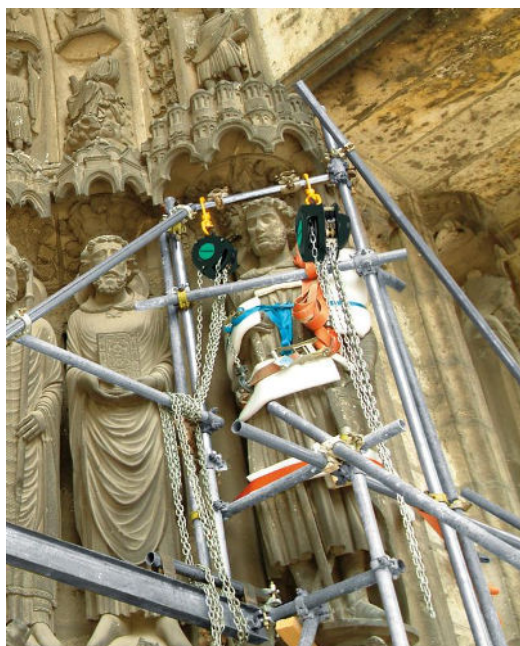
Installation sur échafaudage
