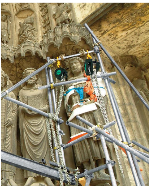
Installation sur échafaudage
