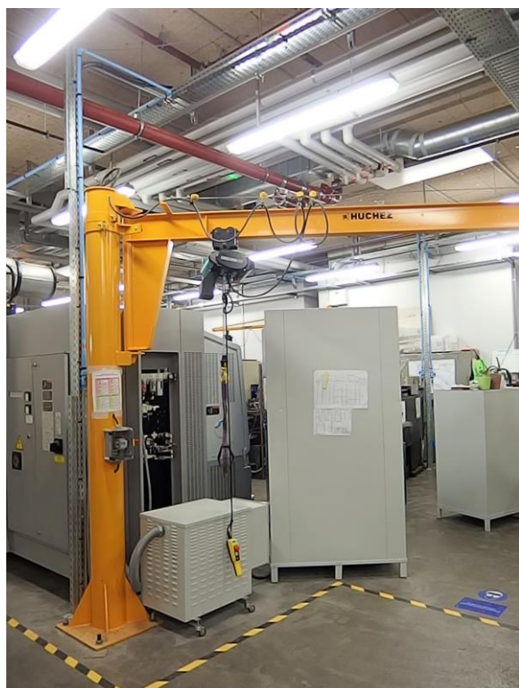
Installation sur portique avec un chariot manuel
