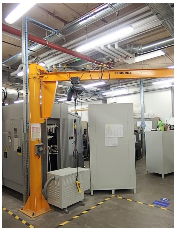
Installation sur portique avec un chariot manuel
