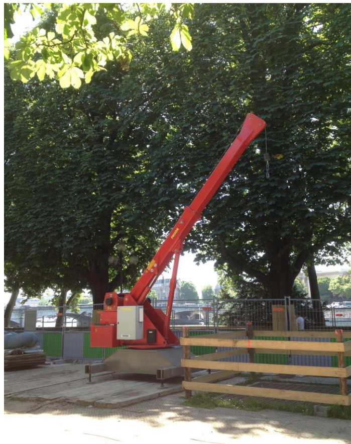
Travaux de réseaux
