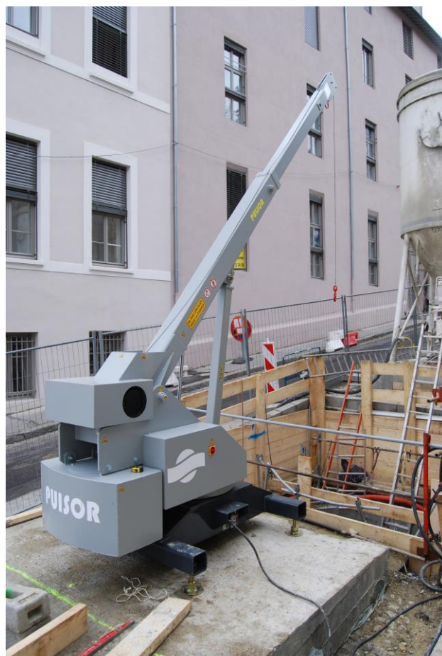
Travaux de réseaux
