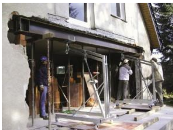
Mise en place d'une poutre sur chantier
