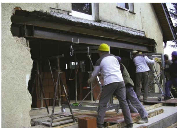
Mise en place d'une poutre sur chantier
