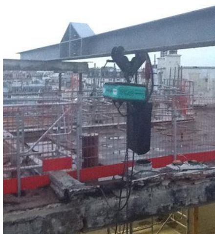
Installation sur fer avec un palan électrique à chaîne
