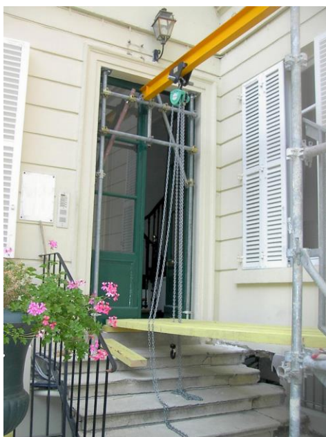
Installation sur fer avec un palan manuel
