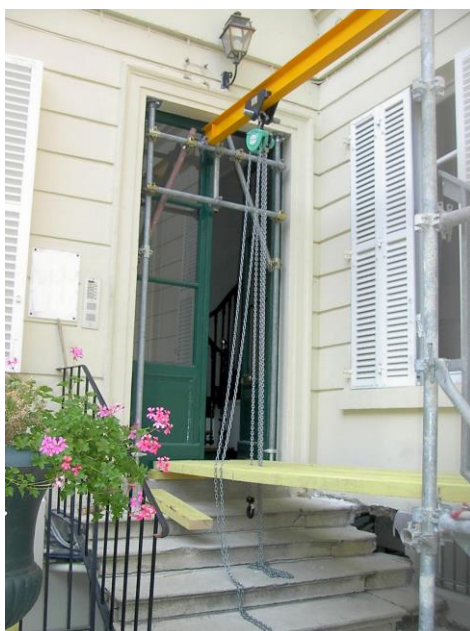
Installation sur fer avec un palan manuel
