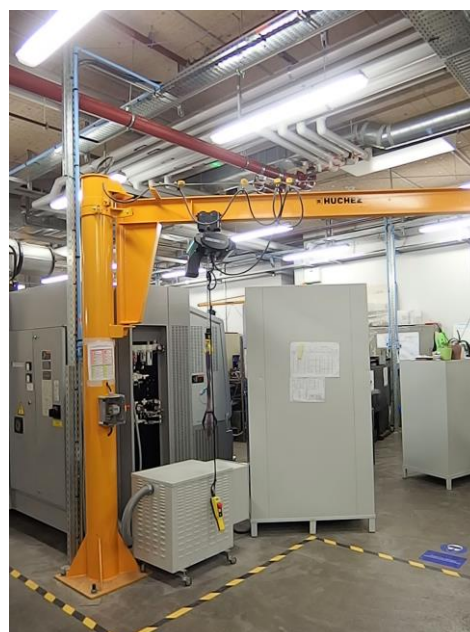
Installation sur portique avec un palan électrique
