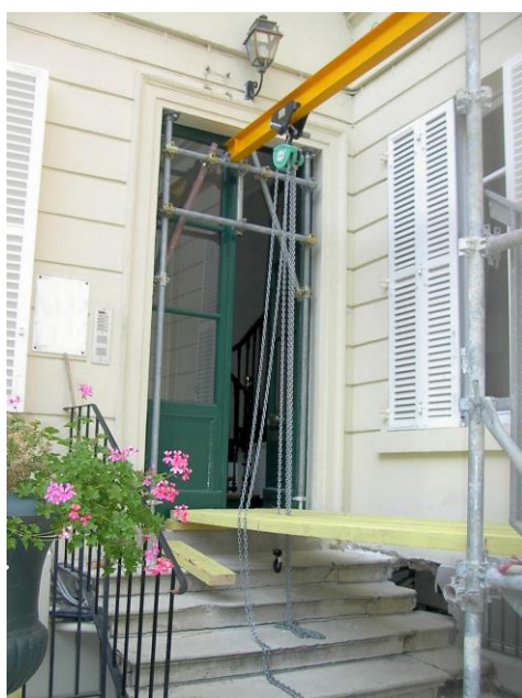
Installation sur fer avec un palan manuel
