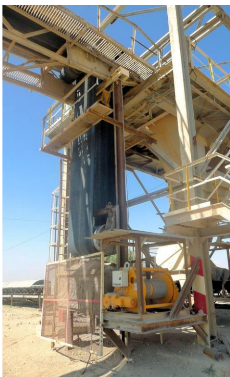
Installation en carrières
