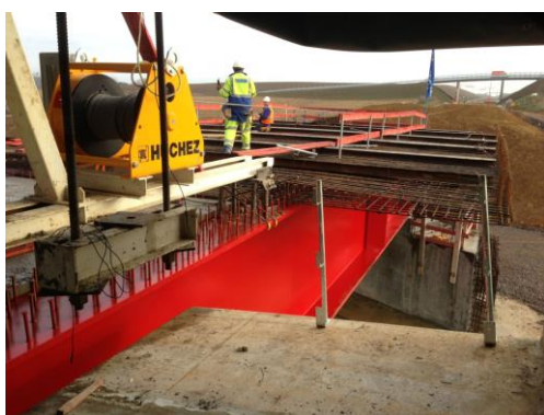
Utilisation sur un ouvrage d'art
