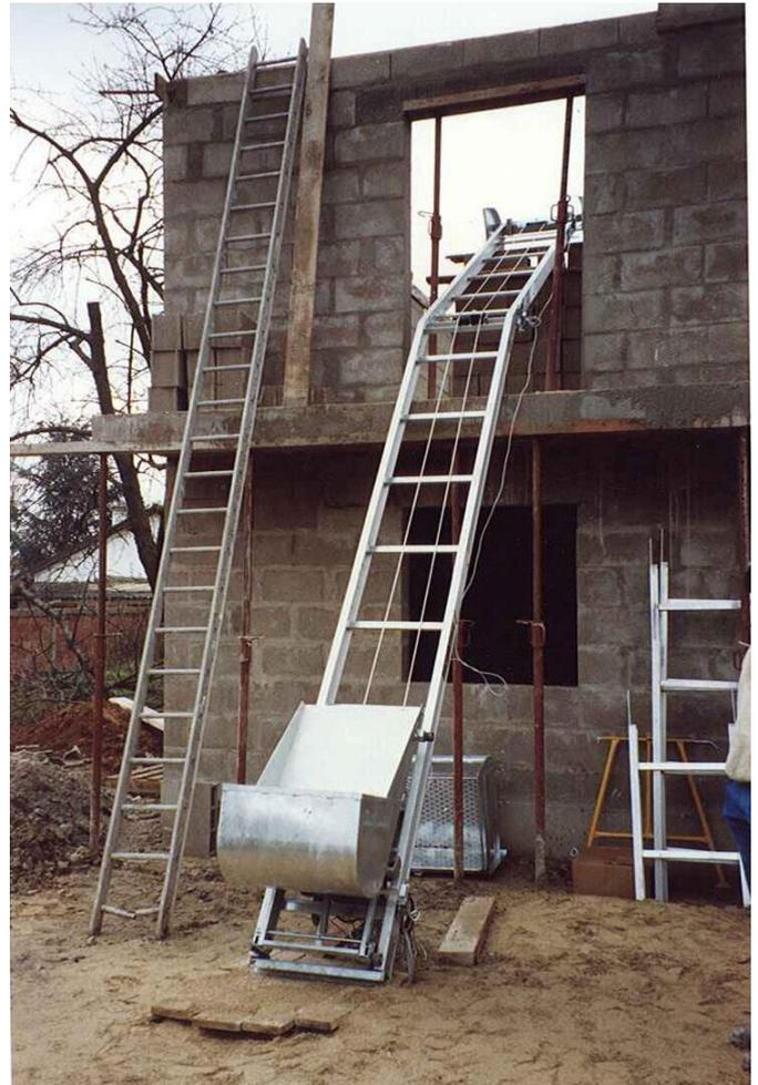
Benne à béton basculante 85 l
