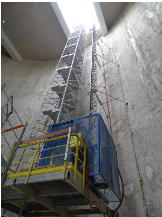
Installation dans une trémie
