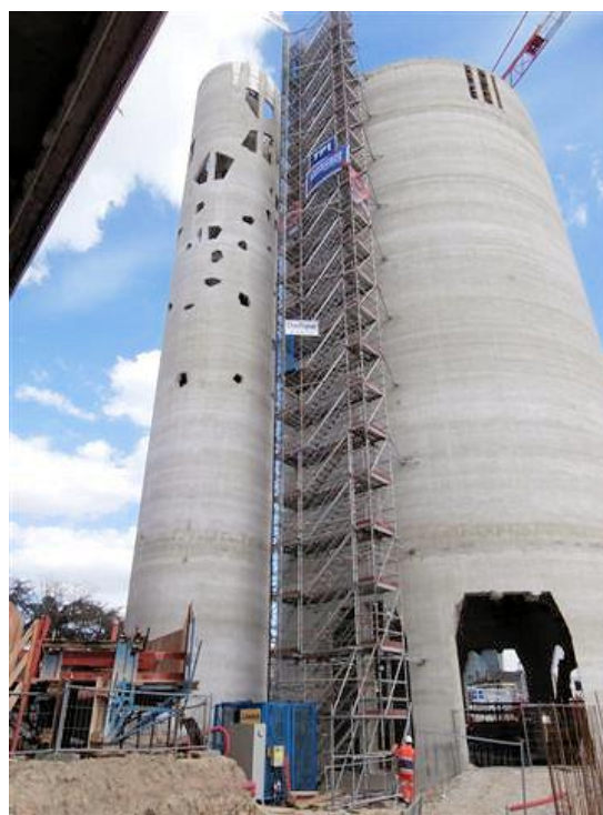
Installation sur échafaudage
