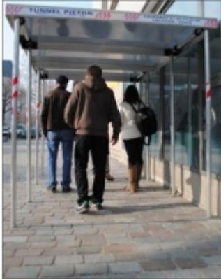
Tunnel permettant de faciliter la circulation et de protéger les piétons durant la période de déploiement de l'échelle d'un véhicule monte-meubles. très utilisé dans les lieux fréquentés ou aux abords des trottoirs.
