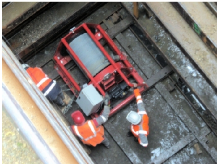
Travaux de réseaux
