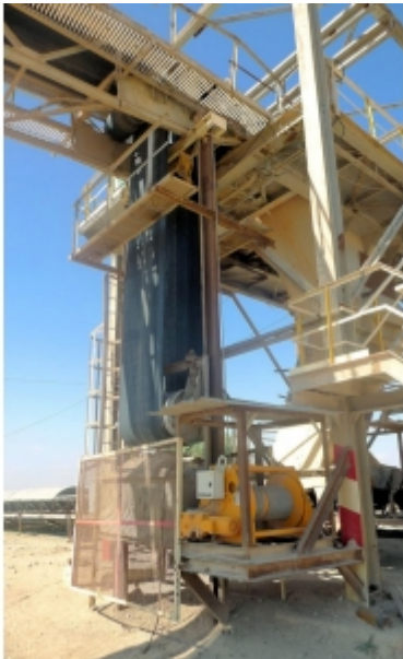
Installation en carrières
