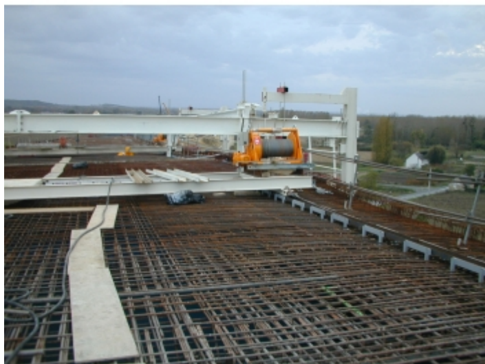
Installation sur un ouvrage d'art
