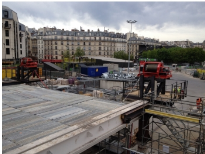
Installation pour la construction d'un immeuble
