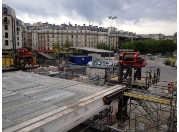
Installation pour la construction d'un immeuble
