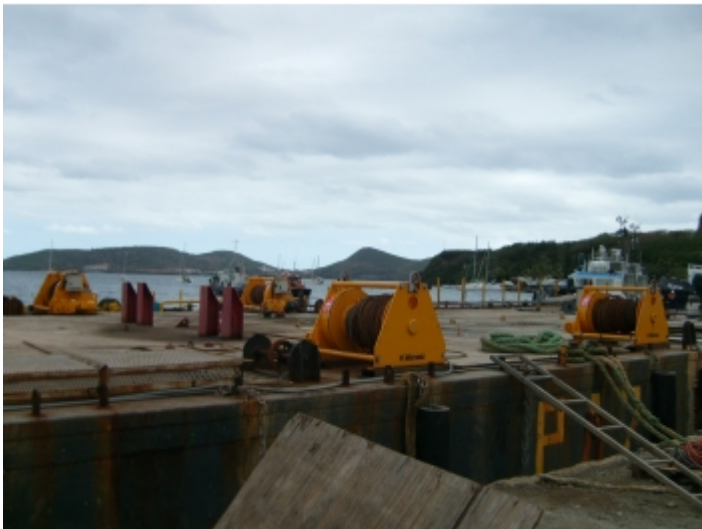
Installation dans un port maritime
