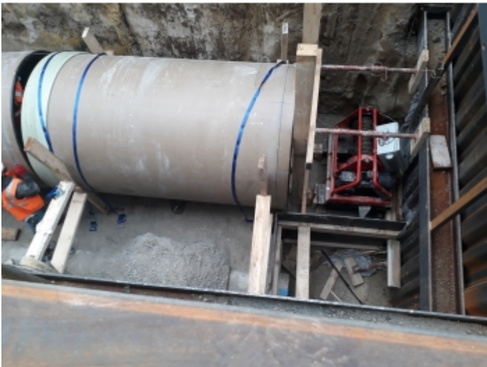
Installation dans un tunnel
