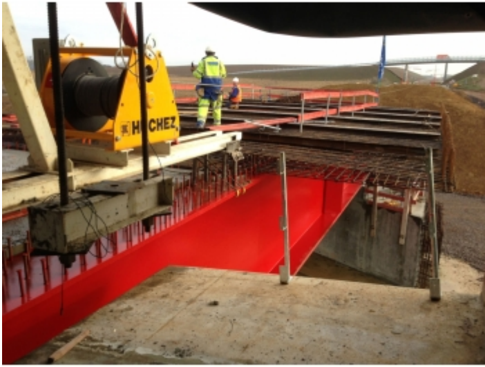
Installation sur un ouvrage d'art
