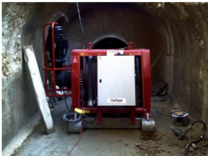
Travaux de réseaux
