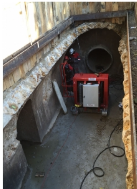
Travaux de réseaux
