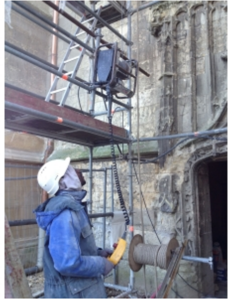
Fixation sur échafaudage
