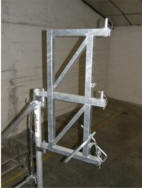
Installation de la rehausse sur la structure
