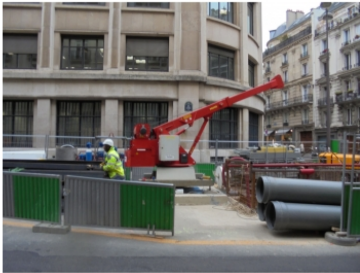
Travaux de réseaux
