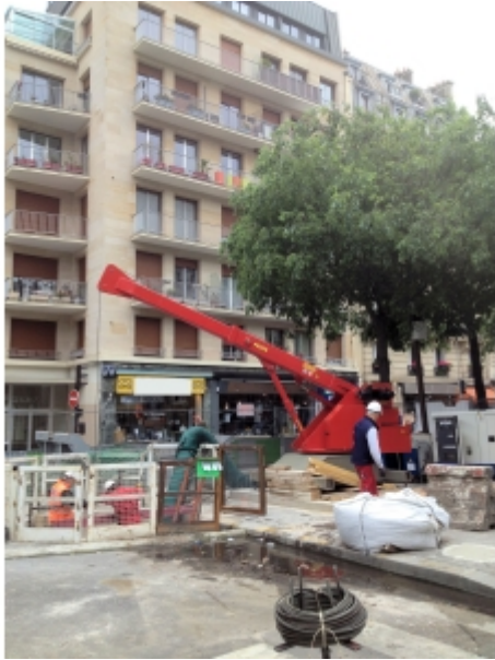
Travaux de réseaux
