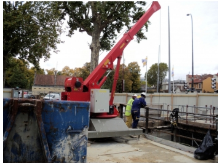
Travaux de réseaux
