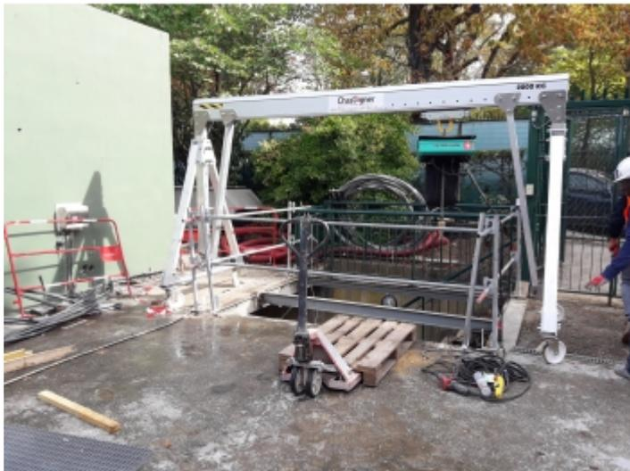
Installation avec un palan électrique à chaîne
