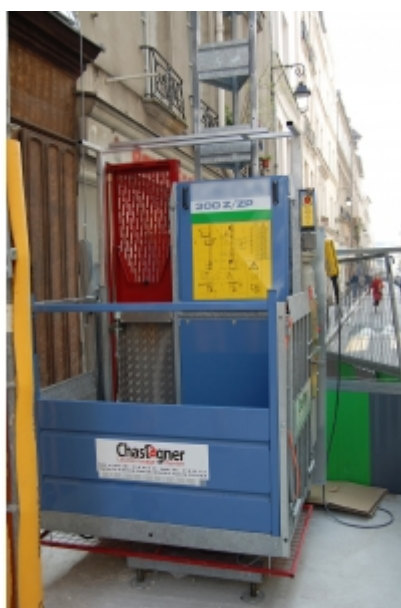
Installation sur chantier en monte-matériaux
