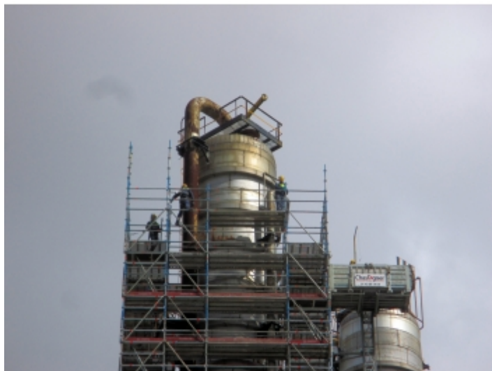
Installation sur échafaudage
