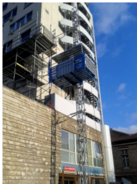
Installation sur échafaudage
