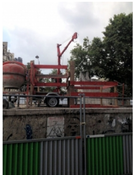
Travaux de réseaux
