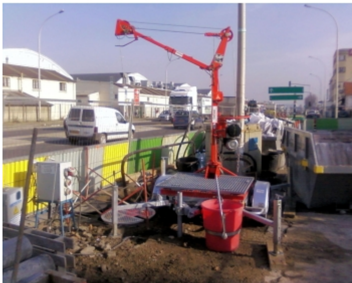
Travaux de réseaux
