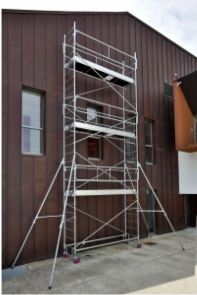
Rénovation d'un bâtiment
