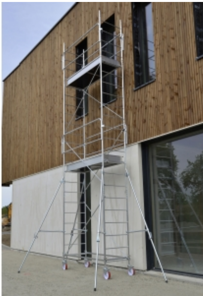
Rénovation d'un bâtiment
