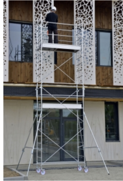
Rénovation d'un bâtiment
