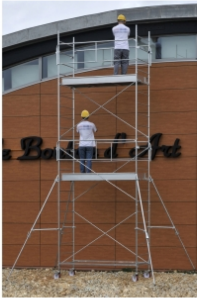
Rénovation d'un bâtiment
