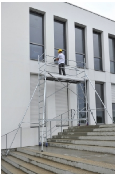
Rénovation d'une façade d'un immeuble
