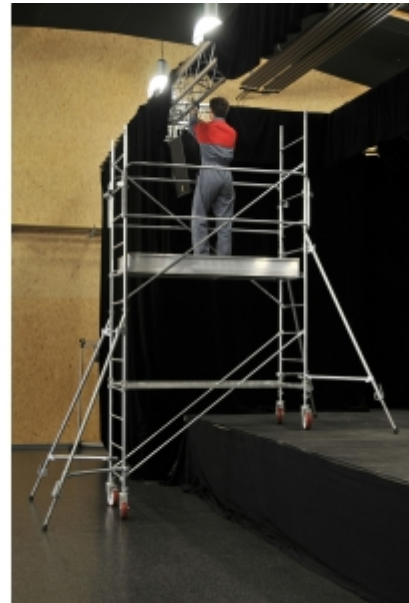
Installation en intérieur
