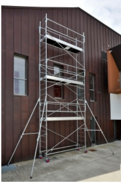
Rénovation d'un bâtiment
