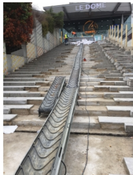
évacuation de gravât
