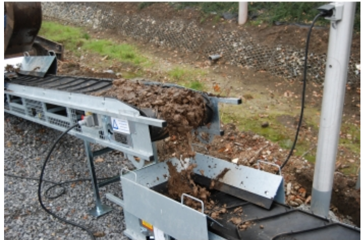
évacuation de gravât
