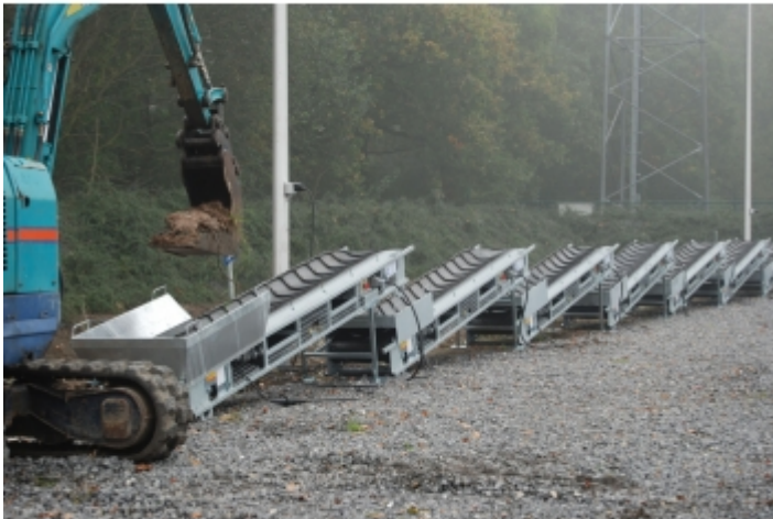
évacuation de gravât
