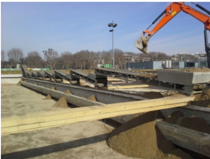
évacuation de gravât
