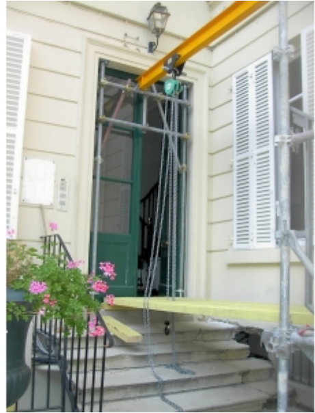
Installation sur fer avec un palan manuel
