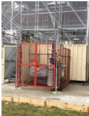
Rehausse pour plate-formes de transport. Élément support servant à installer des plaques (ex : Placoplatre ou bois) à la diagonal dans la plateforme de transport. Dans les versions monte-charges avec accompagnant, la rehausse est toujours accompagnée d'une toiture.
