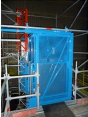
Porte coulissante pour ascenseurs de chantier 800 kg/1 000 kg. A chaque étage desservi, une porte palière à ouverture latérale sécurise le niveau par sa conception qui interdit son ouverture sans la présence de la cabine d'ascenseur. Deux types de porte coulissante sont disponibles : mécaniques ou solénoïdes.
