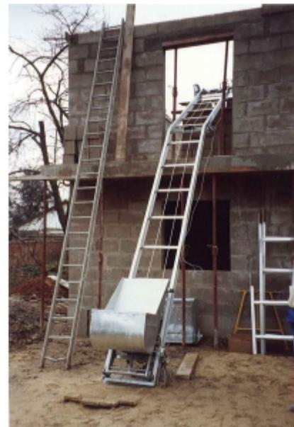
Benne à béton basculante
