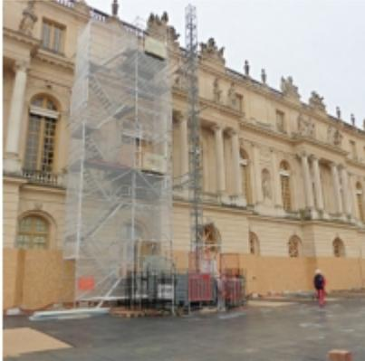
Encagement sur mesure pour monte-charges. Un encagement bas sécurisé interdit l'accès sous la cabine du monte-charges lorsque celui-ci est en hauteur. Equipé d'une porte deux battants simple, il permet aussi de fermer et de sécuriser l'encagement installé en partie basse interdisant l'accès sous la cabine du monte-charges lorsque celle-ci est en hauteur ou en mouvement. CHASTAGNER étudie pour vous les caractéristiques de votre emplacement et met en place un encagement sur-mesure.
